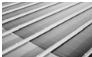
Abb. 4: Amorphe Solarzellen als integrale Bestandteile der Paneele eines Metalldachs
