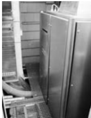
Abb. 6: Die Abluftwärmepumpe
