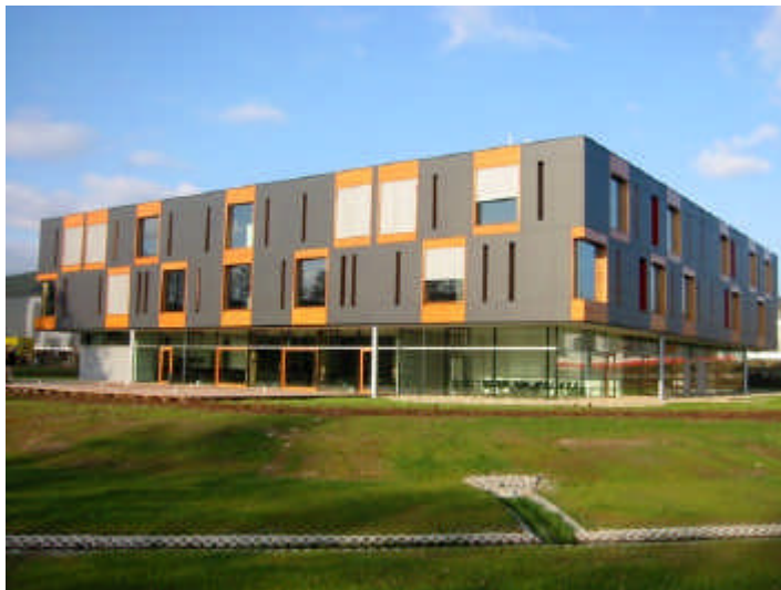
Abb. 1 Südansicht des Gebäudes
