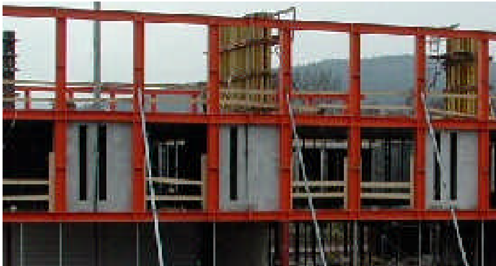
Abb. 17 Betonfertigteile auf der Innenseite der Fassade zur Erhöhung der Gebäudemasse.
