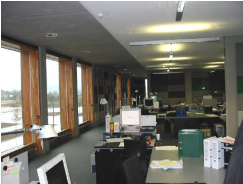
Abb. 19 Ansicht Innenraum 2.OG; Nordseite bei trübem Wetter. An der Decke ist der weiße Mittelstreifen erkennbar (eine Teilabhängung, die gleichzeitig raumakustische Funktionen übernimmt)
