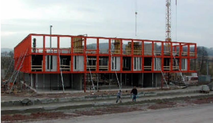
Abb. 6 Stahlskelettkonstruktion des Gebäudes. Im EG sind bereits die vorgefertigten Wandelemente aus Beton zur Erhöhung der internen Masse des Gebäudes erkennbar.
